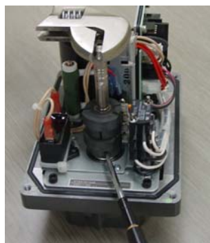
図 12-13(b) 閉側カム調整
