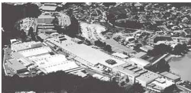
長坂工場 高圧ガス認定事業所
