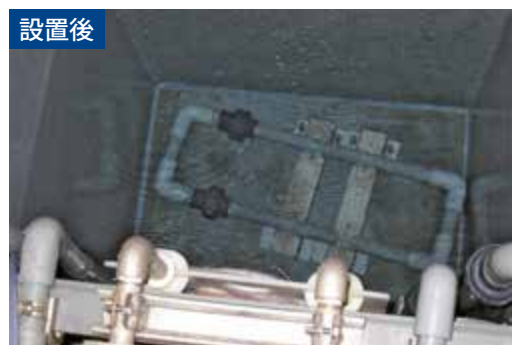
※配管洗浄から1ヶ月後
